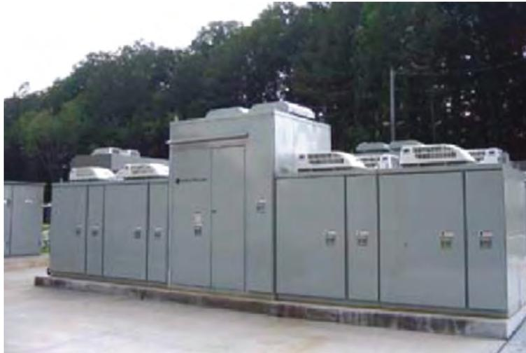
**El Sistema UPS PureWave** proporciona un mejor servicio continuo a las instalaciones abastecidas de una sola fuente de energía, en donde las interrupciones momentáneas son una preocupación. Los modelos con capacidad de 380 a 600 volts respaldan cargas de hasta 2500 kVA y los modelos de 4.16 a 25 kV respaldan cargas de hasta 20 MVA.
